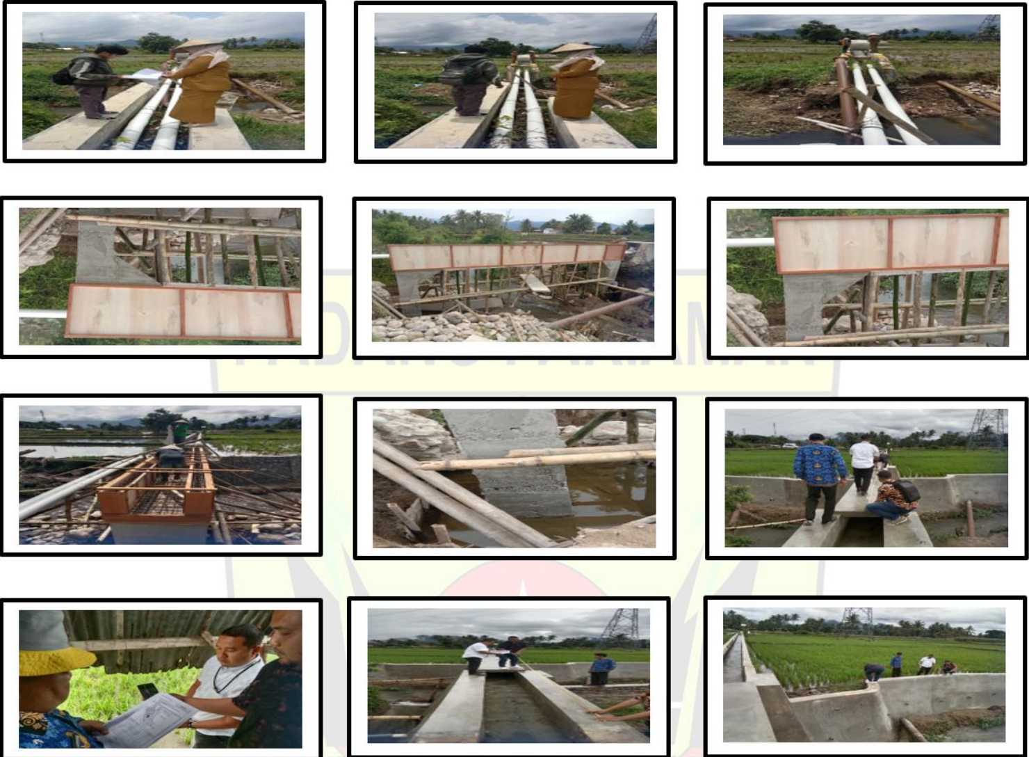
Gambar 3 6 Pembangunan/Rehabilitasi Saluran air pasok dan/atau buang UPTD BBI Lubuk Alung
